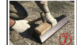
⑦ 傷がつかないように垂木などで保護し、叩いて製品を挿入し接着剤が硬化（約1日間）すれば完成です。はみ出た接着剤は乾く前に拭き取ってください。
