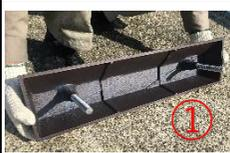
① 本体にボルト 2本を30mm程度の深さで取付けます。
