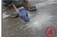
④ 穴の中に残った削りかすをエアブローして取除きます。
