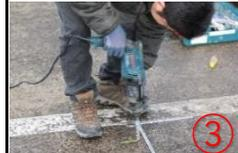
③ コンクリート面に22mm径以上の穴を掘ります。
