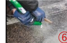
⑥ 本体接地面・ボルトに接着材を塗布、穴に接着剤を注入します。
