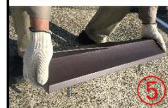
⑤ ボルトが穴底に到達した際、接地面と本体に隙間がないかを確認します。
