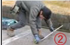
② 設置位置を確認し穴をあける位置に印をつけます。※ボルトの間隔（穴あけピッチ）は約40cm（エアロタイプは約54cm）です。商品に合わせ印をつけてください。※水分がないことを確認。
